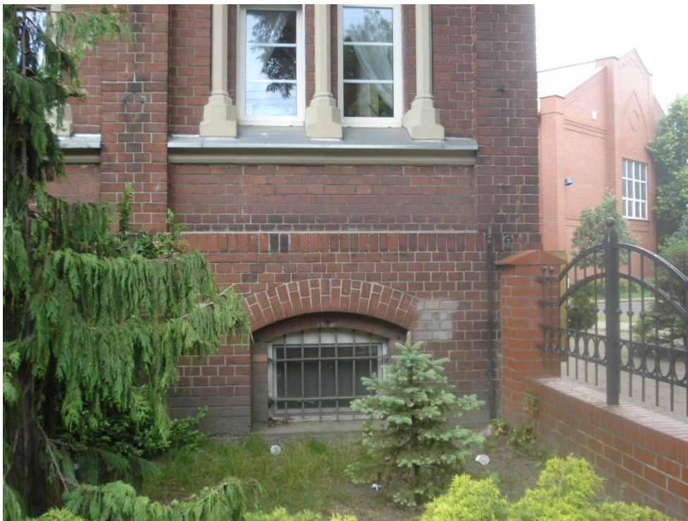
Fot. nr 3 Elewacja frontowa (wschodnia). Widok na istniejące okno po prawej stronie.
