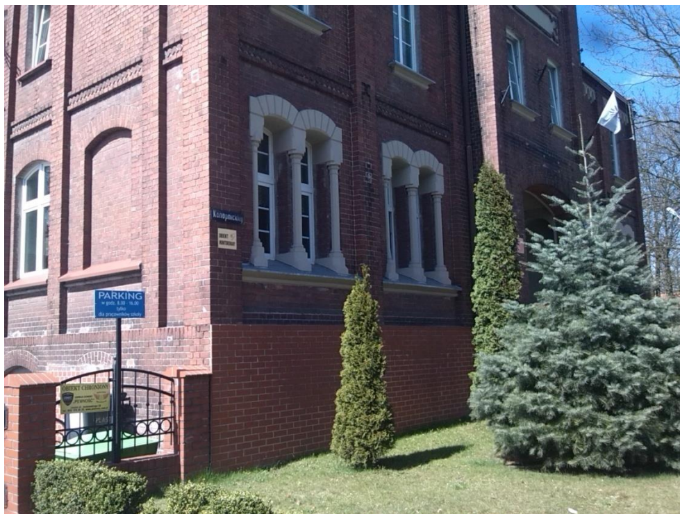
Fot. nr 1 Elewacja frontowa wschodnia. Widok na pas cokołu w którym zaprojektowano okna piwniczne.
